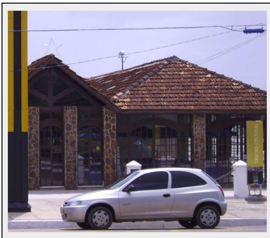
FOTO 20: Fachada do Praia-Bar onde funciona um PIT, na Vila. Foto: Costa, 2006.
