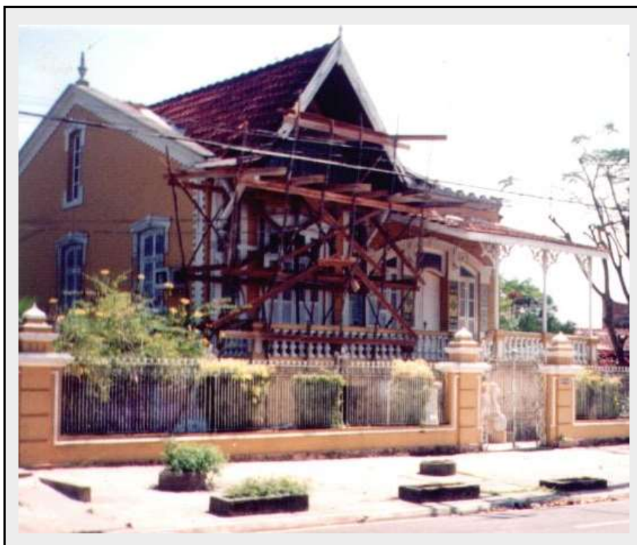
FOTO 21: Visão de um chalé sendo reformado no Farol. Foto: Costa, 2003.
