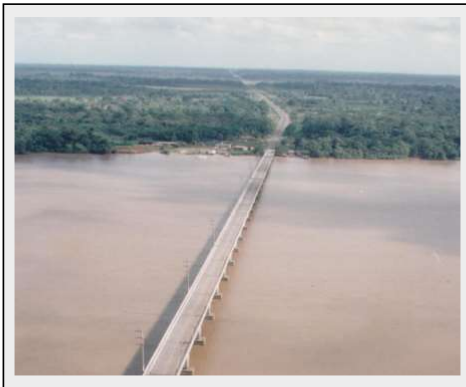
FOTO 10: Perspectiva aérea da ponte sobre o Furo das Marinhas. Foto: SEGEP, 1993.
